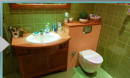
... i nowa bidetotoaleta po instalacji
