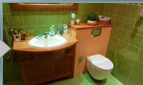
... i nowa bidetotoaleta po instalacji.
